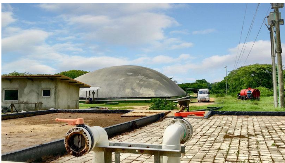
Il·lustració 51. Biodigestor llacuna anaeròbica de mitjana-baixa tecnologia
