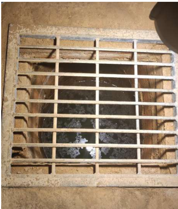
Imatge 40: Pou de drenatge del refugi antiaeri de la plaça de la Patacada de Reus. (Autor: Polvoró).
