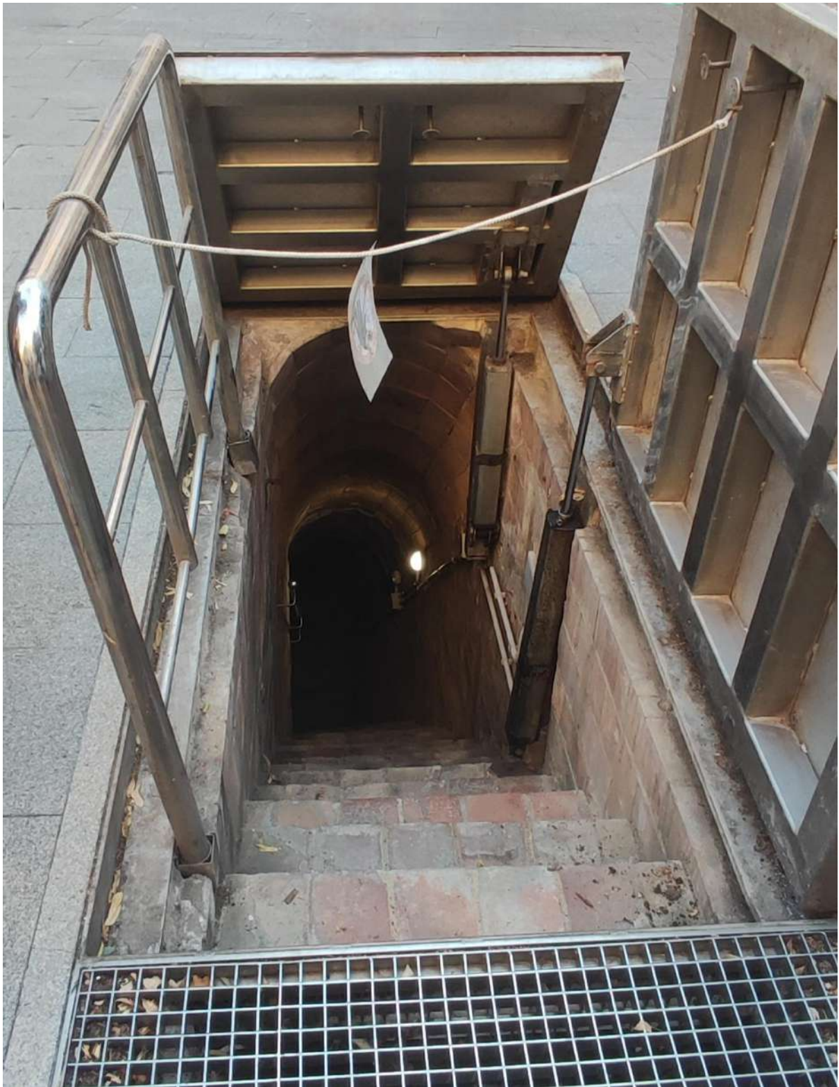
Imatge 26: Imatge de l'accés i les escales ubicades a la plaça de l'Església de Santa Maria de Cambrils que s'utilitzen per entrar al refugi antiaeri del carrer Creus. (Autor: Polvoró).
