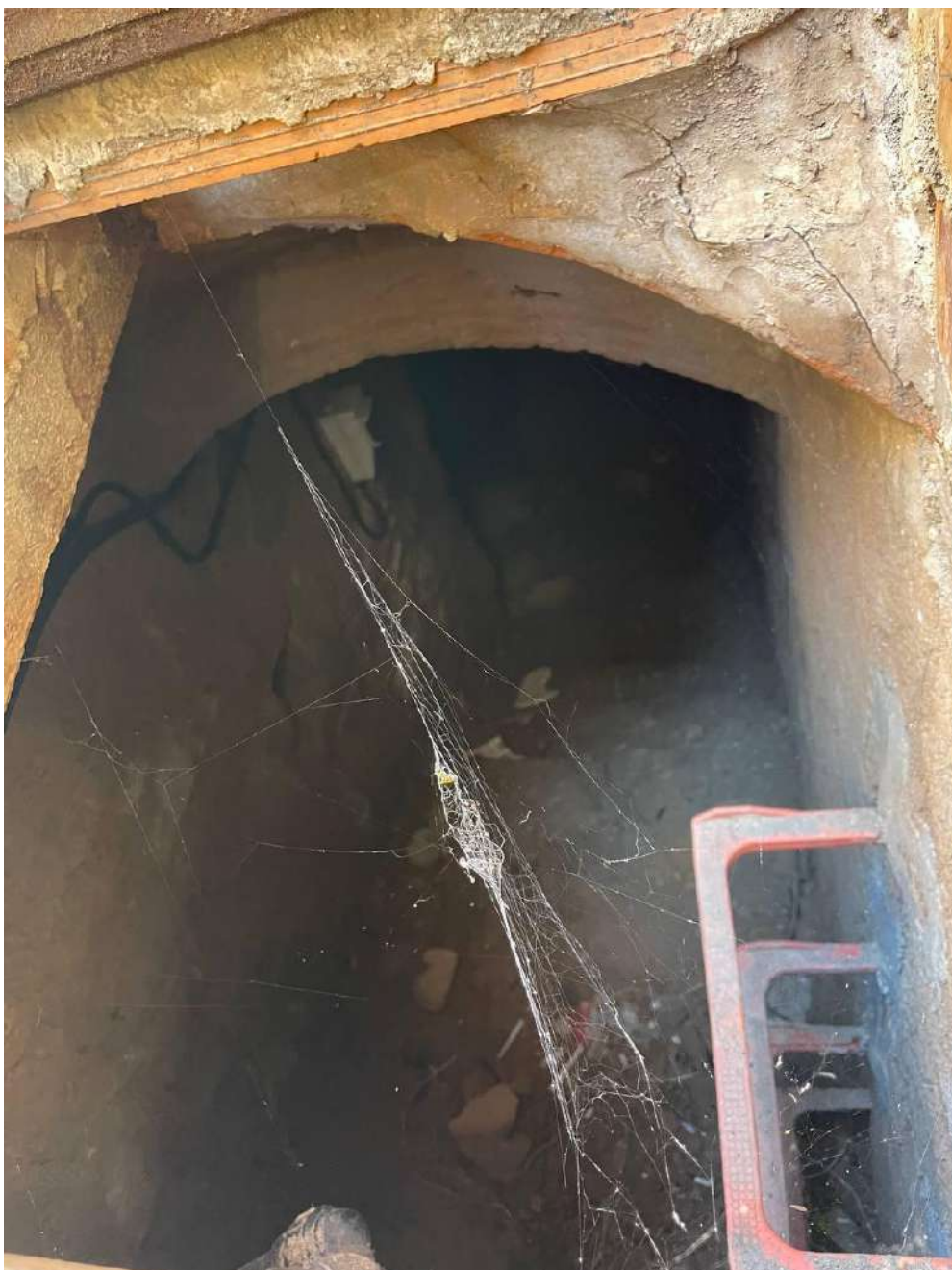
Imatge 64: Interior del refugi antiaeri de les escales de l'església de Santa Maria. (Autora: Maria del Pilar Herrerias).
