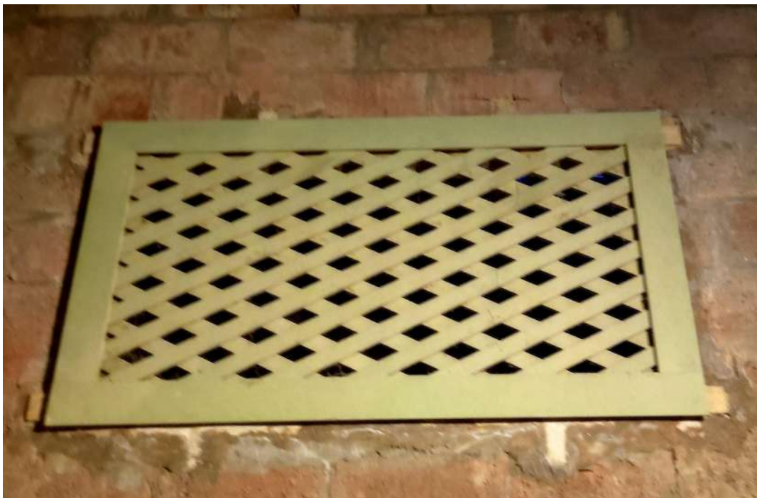
Imatge 16: Respirador per ajudar en la ventilació del refugi antiaeri de Valls. (Autor: Polvoró).
