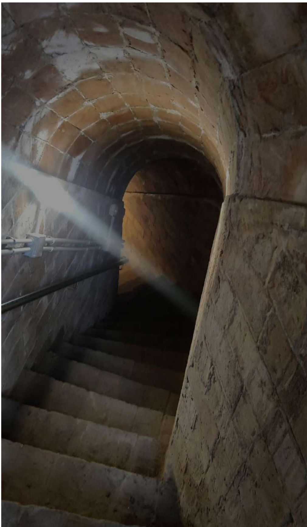
Imatge 28: Imatge de les escales que donen a l'accés ubicat al carrer Creus que s'utilitzen per sortir del refugi antiaeri del carrer Creus de Cambrils. (Autora:Diana Ciufudean).
