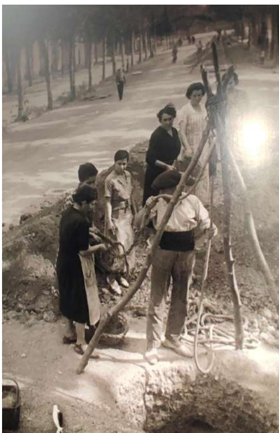
Imatge 37: Extracció de terra de l'excavació d'una de les galeries del refugi del passeig de sunyer de l'any 1938. (Arxiu Abadia de Montserrat / Fons Ramon Perera).
