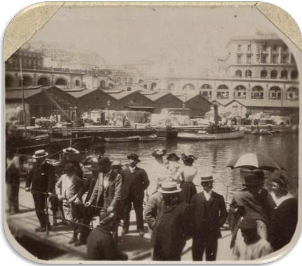
Image 22 : Embarcadère à Alger © ANOM. Source : https://www.inshs.cnrs.fr/fr/cnrsinfo/les-europeens-en-algerie-1830-1962-naissance-dune-population-et-construction-des-identites
