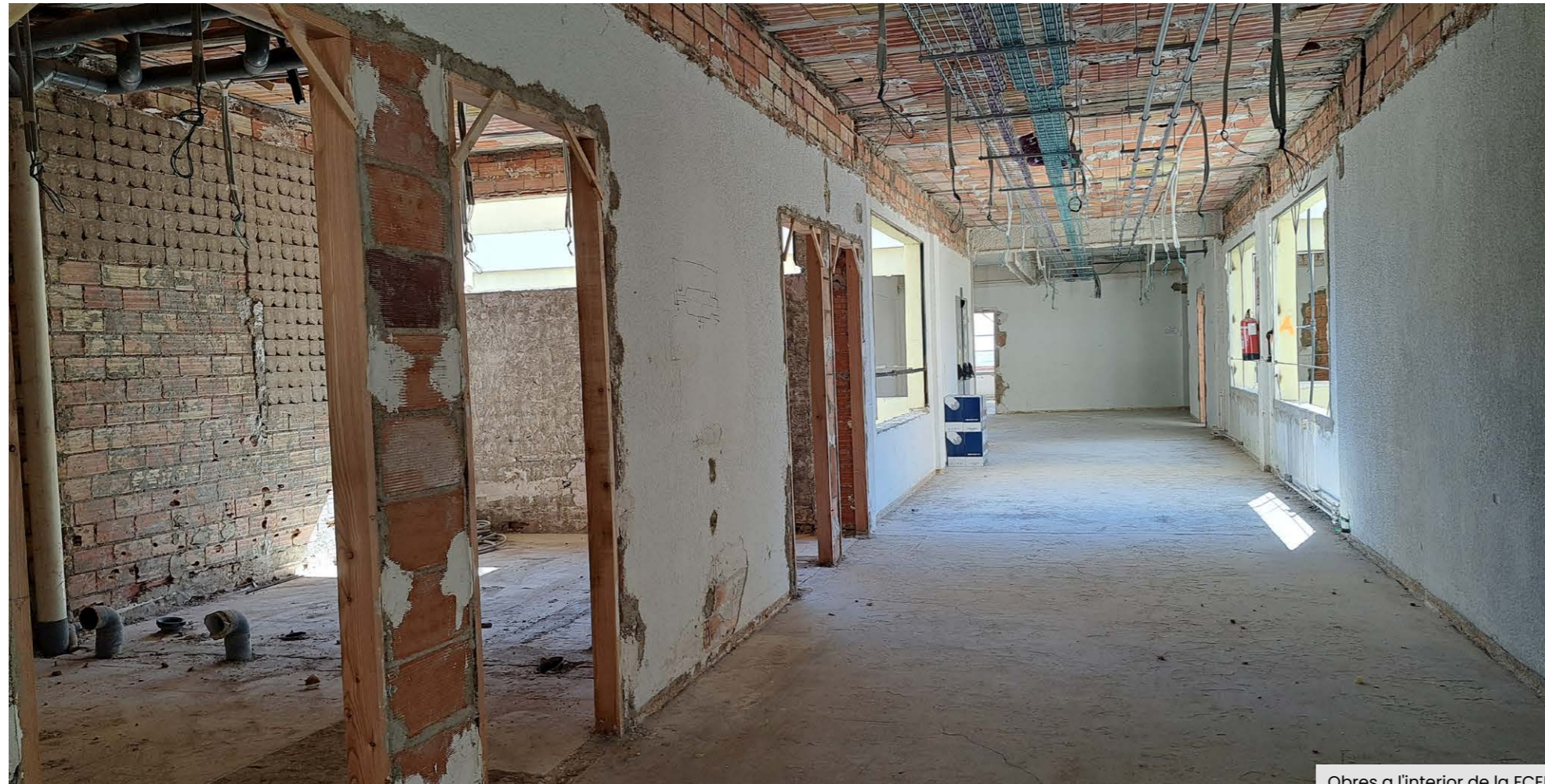
Obres a l'interior de la FCEP.
