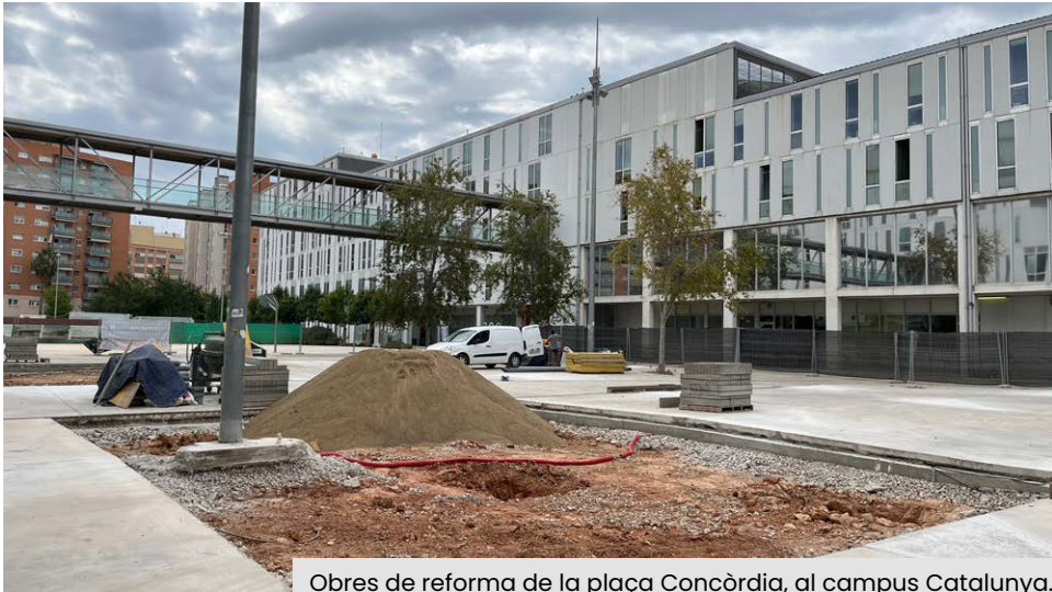
Obres de reforma de la plaça Concòrdia, al campus Catalunya.
