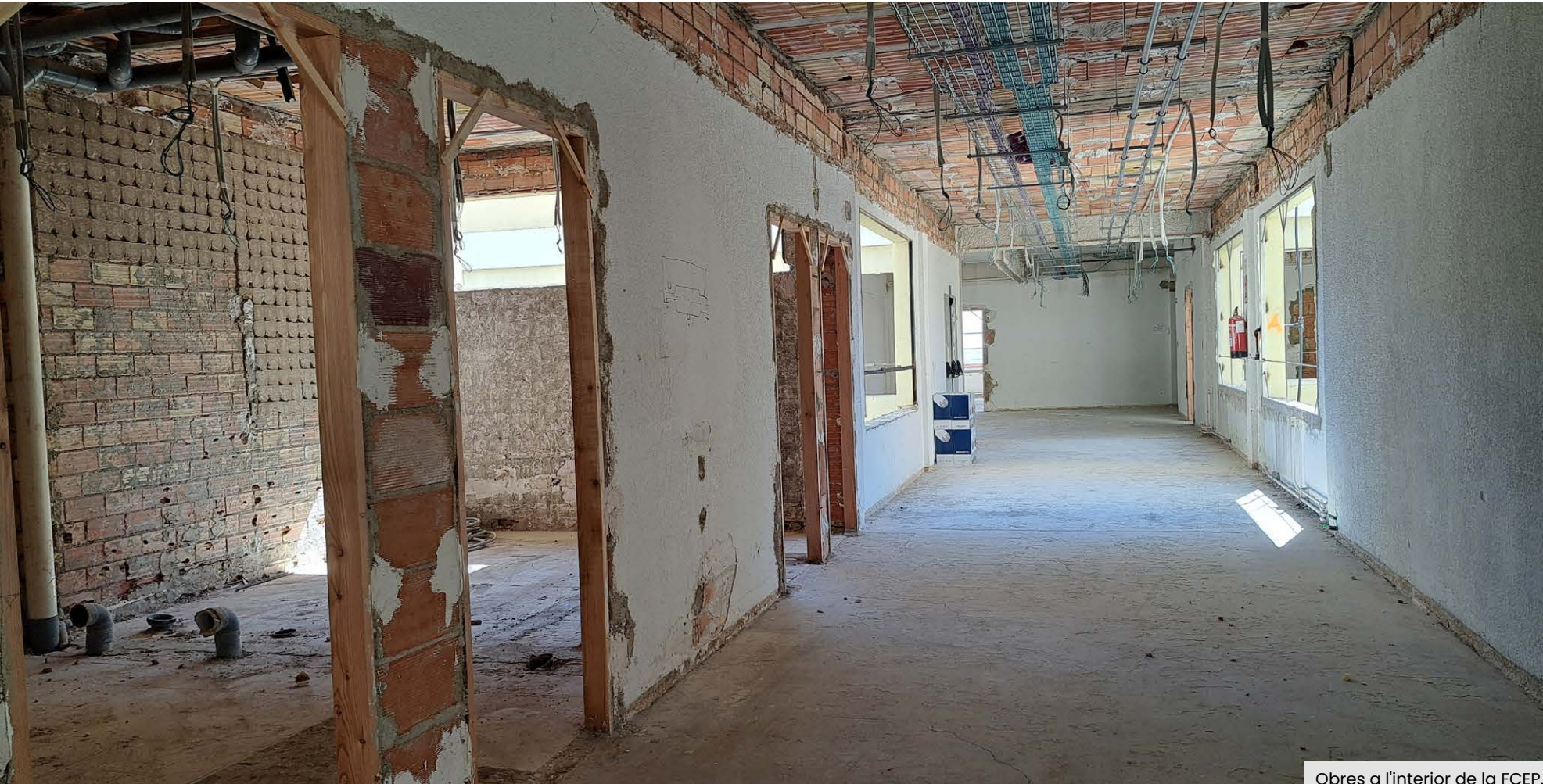
Obres a l'interior de la FCEP.
