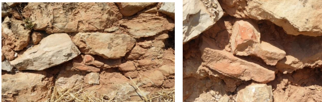
Fragments de teula tipus tegula utilitzats per falcar o reomplir el mur de pedra seca
