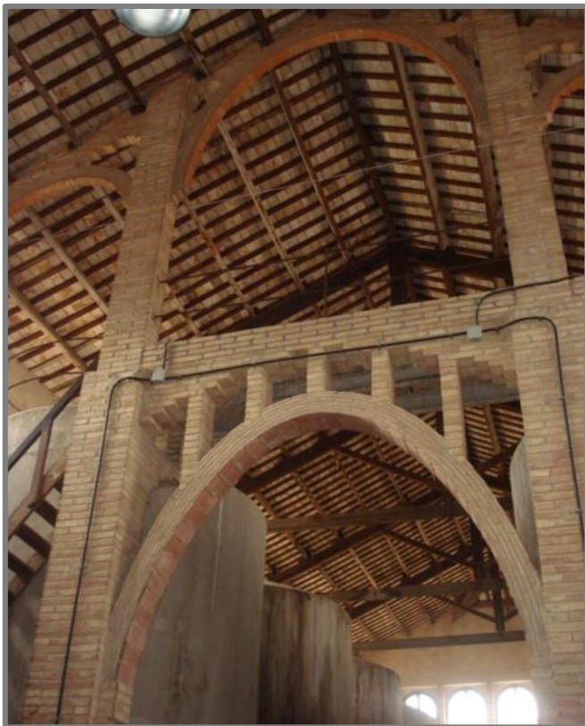
IL·LUSTRACIÓ 6: ARCS CATENARIS SOBREPOSATS DEL S. A. A. (FONT: FOTOGRAFIA PRÒPIA)
