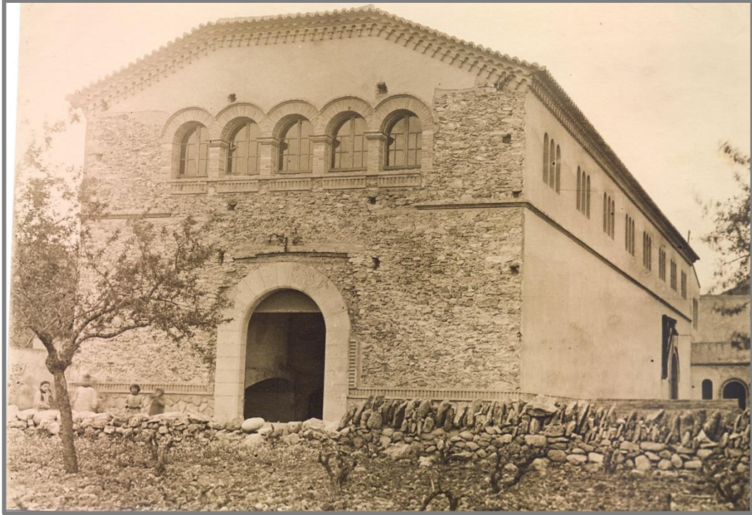
IL·LUSTRACIÓ 15: DURANT LA CONSTRUCCIÓ DEL CELLER, NOTABLEMENT AVANÇADA. (FONT: MUSEU DE VALLS)
