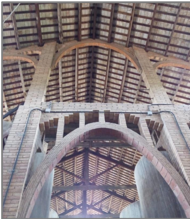
IL·LUSTRACIÓ 10: ARCS CATENARIS, BIGUES DE FUSTA I ENCAVALLADES DEL S. A. A. (FONT: FOTOGRAFIA PRÒPIA)
