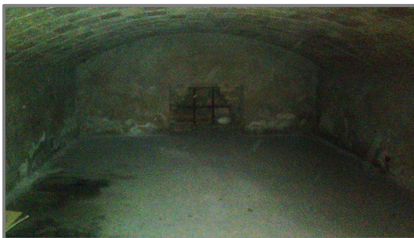
IL·LUSTRACIÓ 5: VENTILACIÓ PER ALS GASOS I ESTRUCTURA D'UNA VOLTA CATALANA DEL S. A. A. (FONT: FOTOGRAFIA PRÒPIA)
