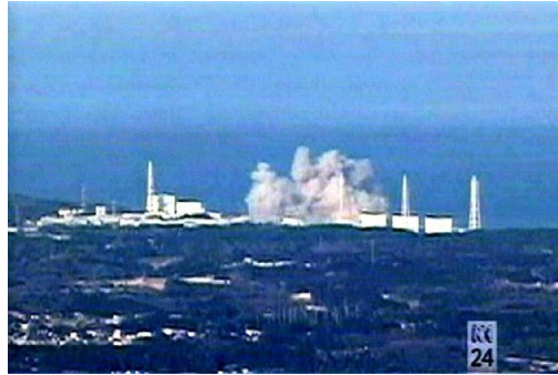
33. Explosió d'hidrogen del reactor 4.
