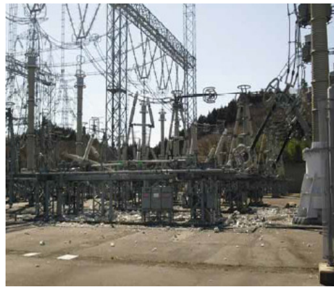
9. Transformador elèctric, que subministra energia a la central de Fukushima I afectat pel terratrèmol.
