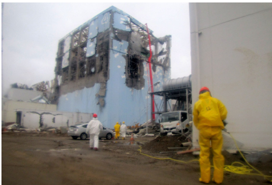
34. Vista del reactor 4 després de l'explosió d'hidrogen en una de les seves plantes.
