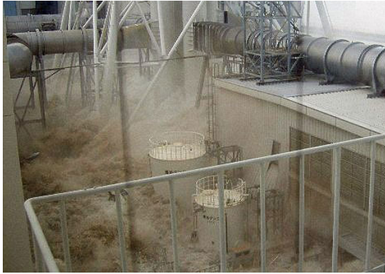
14. Inundació de les instal·lacions de la central de Fukushima Dai-ichi.
