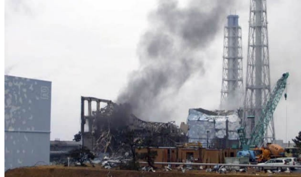
32. Fum sortint del reactor 2, després de quedar greument afectat per una explosió d'hidrogen.
