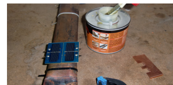
Pegat cèl·lules solars a tub coure refrigerador
