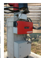
Detalls pantalla inversor i inversor amb quadre elèctric
