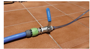
Canonada d'aigua que alimenta el tub de coure
