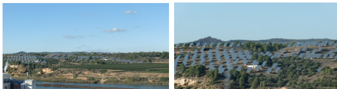
Vistes generals parc solar HCPV
