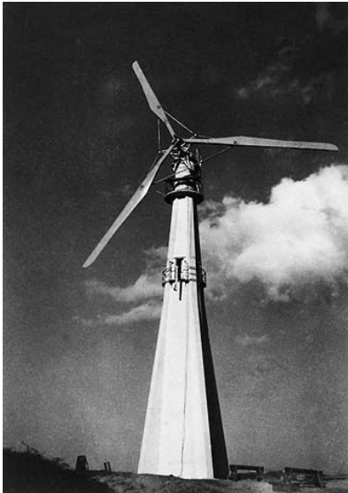
Fig. 5 Aerogenerador de Bogø
