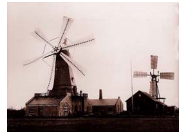
Fig. 4: Dos dels aerogeneradors de prova de La Cour.
