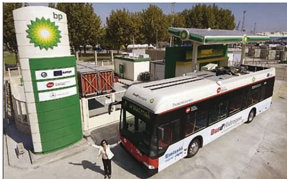
Estació d'hidrogen (Barcelona)
