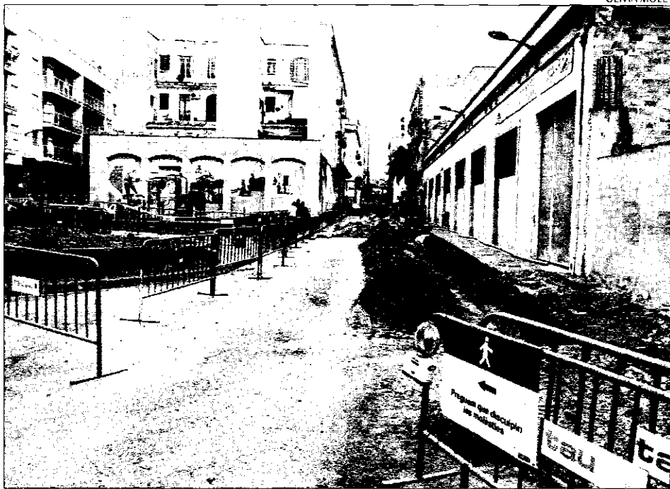
Imatge que ofería ahir l'Avinguda del Carrilet, on ja s'han iniciat les obres.
